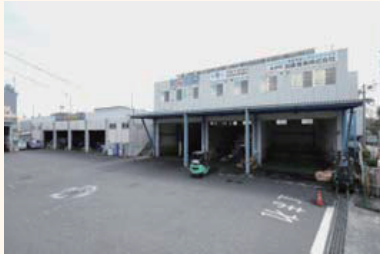
エコ工場フェニックス第一工場
